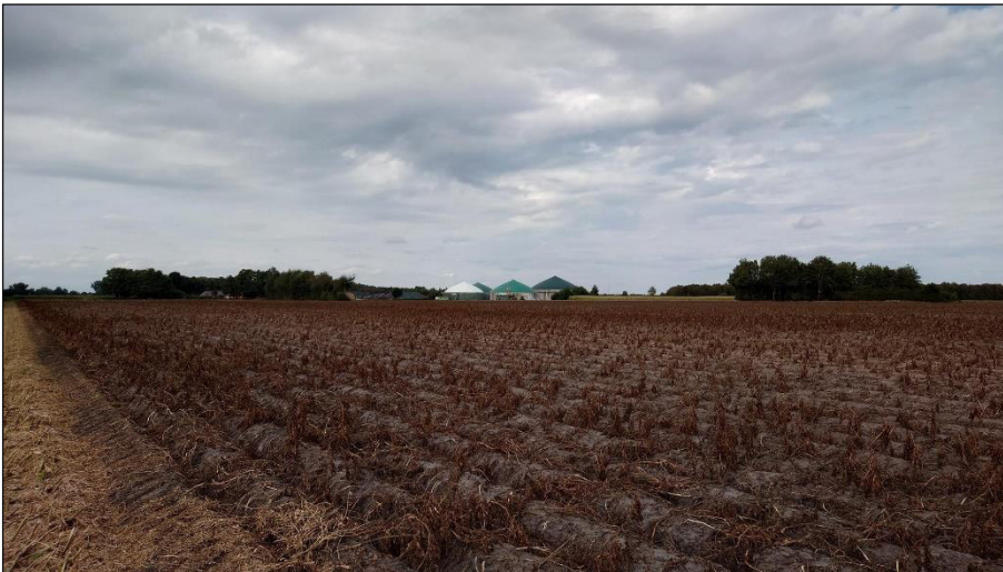
Abb. 2: Blick auf die Biogasanlage, Eingriffsbereich Gülleleitung
