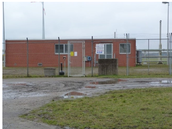
Abbildung A.34: IO36 Gasförderstelle 1 – Gebäude 1
