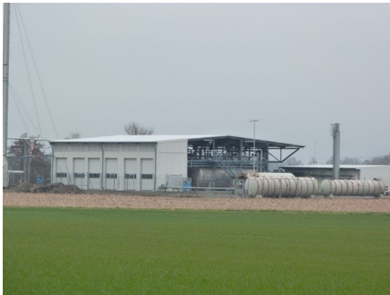
Abbildung A.37: IO37 Gasförderstelle 2
