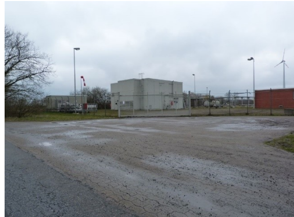
Abbildung A.36: IO36 Gasförderstelle 1 – Gebäude 3
