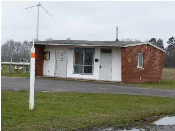
Abbildung A.35: IO36 Gasförderstelle 1 – Gebäude 2
